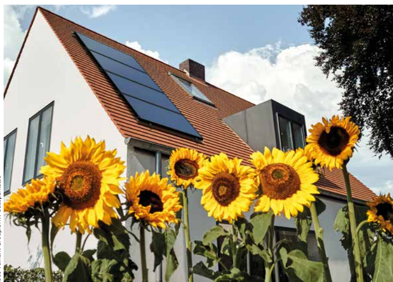
Wer auf umweltfreundliche Energie baut, wird stärker gefördert
