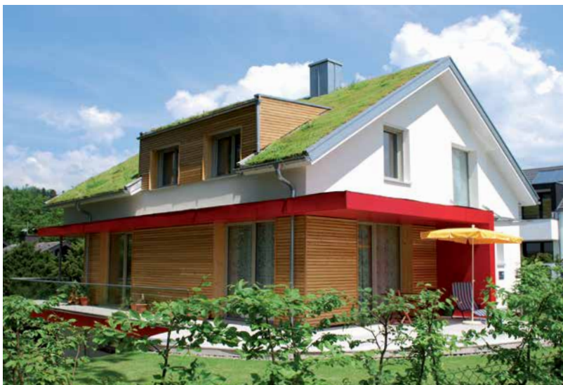
Natürliche Alternative zu Klimageräten: Fassaden und Dachbegrünungen
