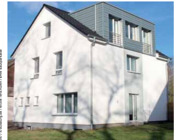
Nachher: Mehrparteienhaus rundum modernisiert
