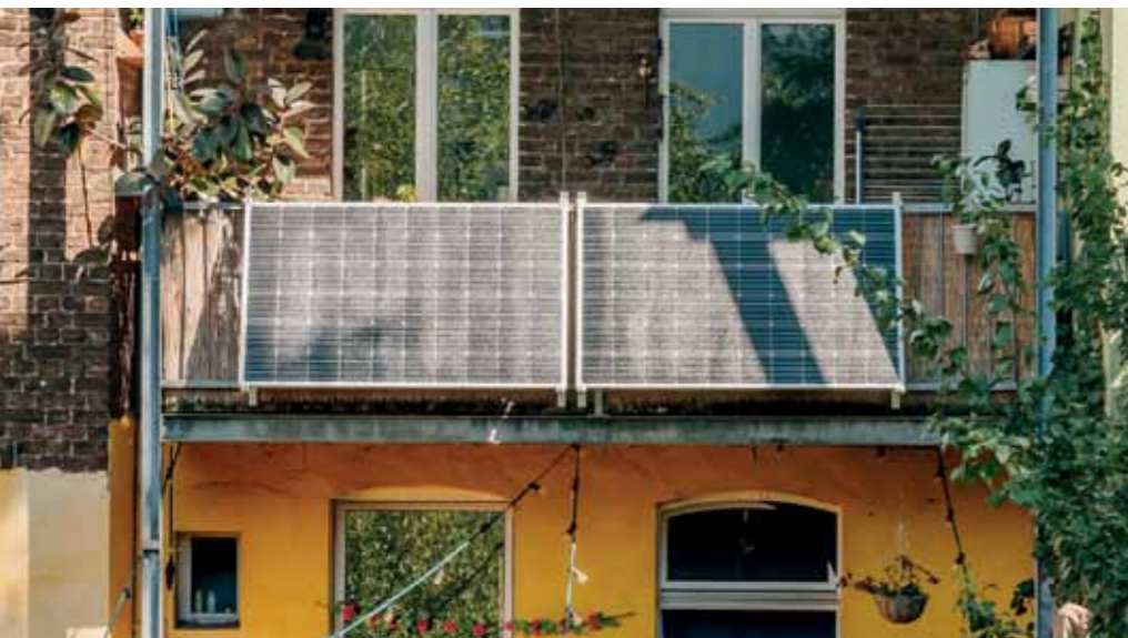
Photovoltaik am Haus – moderne Technik schafft Preisvorteile
