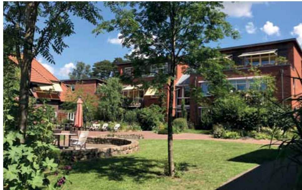
Soll den Sanierungstau auflösen: das neue Wohneigentumsgesetz
