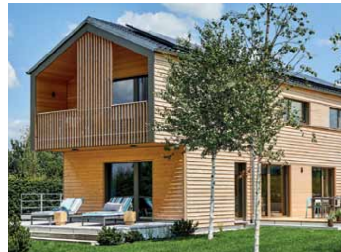
Stark ausbaufähig: Recycling von Baustoffen
