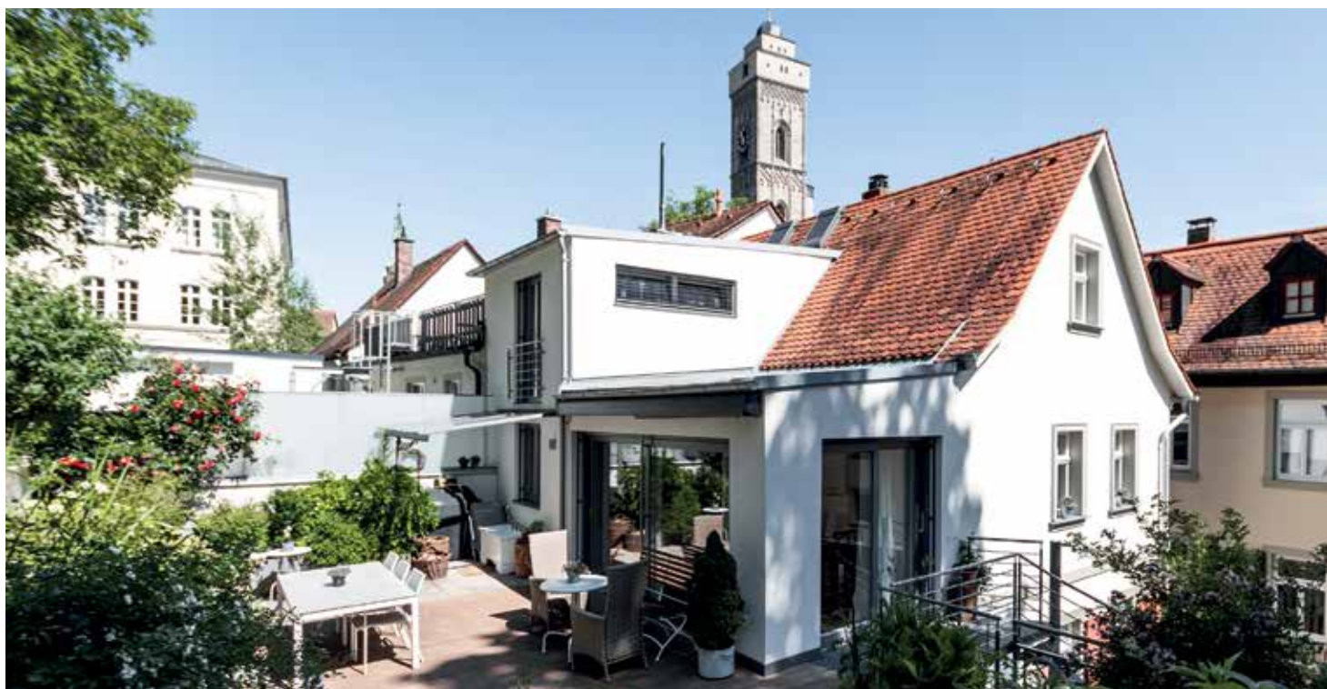
Sinnvoll modernisieren – entscheidend ist die Bauepoche
