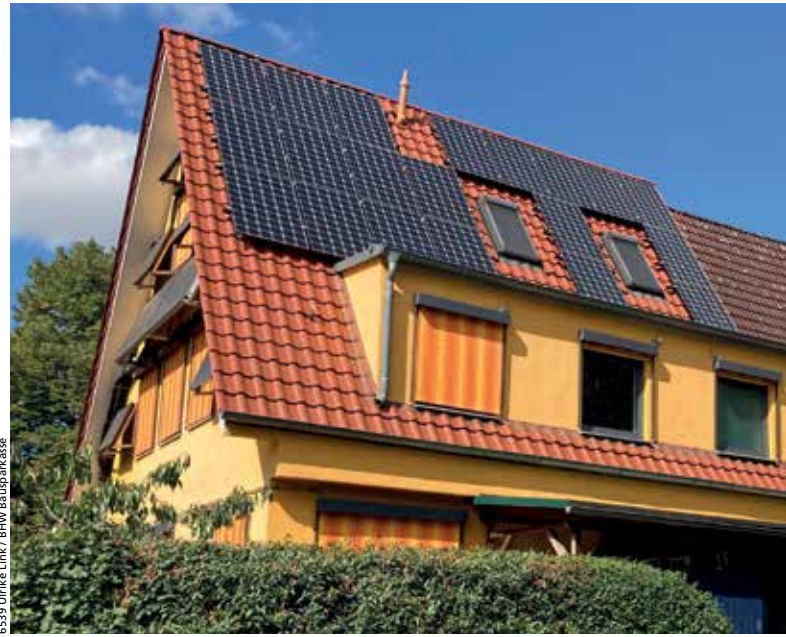
Spar-Option: Erneuerbare Energie vom eigenen Dach
