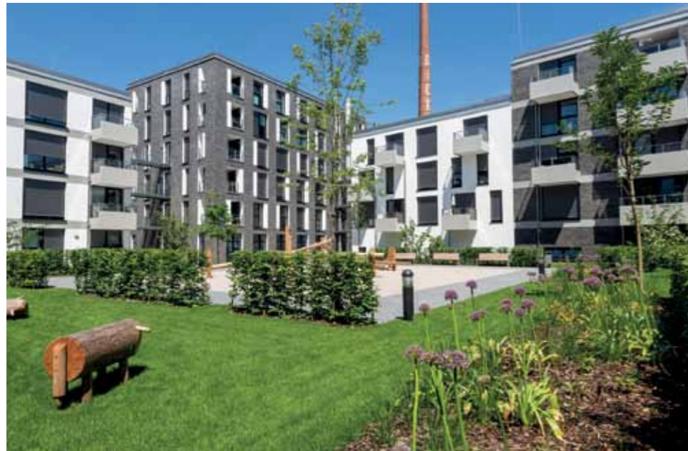
Neues Energiekonzept auf Basis von solarem Wasserstoff – Quartier „Neue Weststadt“ in Esslingen
