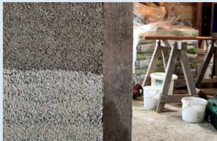
Ein Hanf-Kalk-Haus speichert Wärme ohne zusätzliche Dämmung
